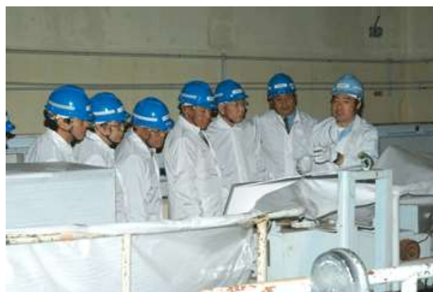
ふげん発電所の視察風景
