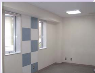
原子力機構 敦賀本部での施工試験
