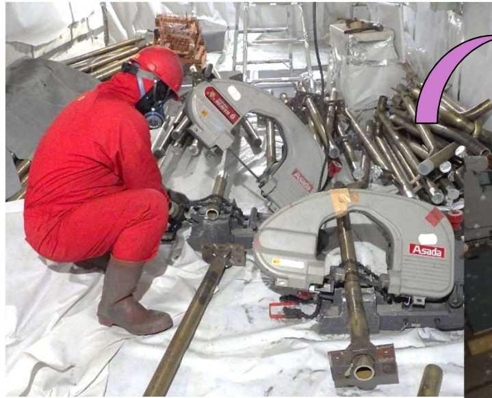
配管の細断作業
