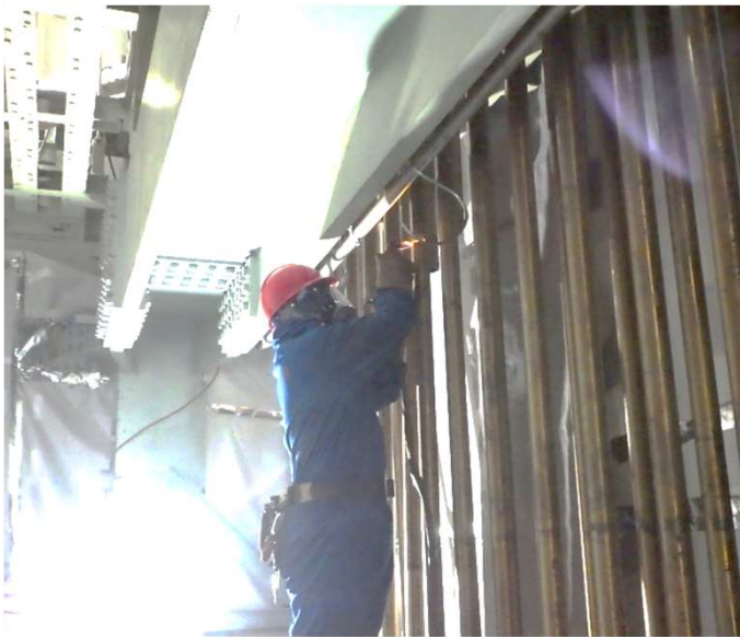
配管の粗断作業
