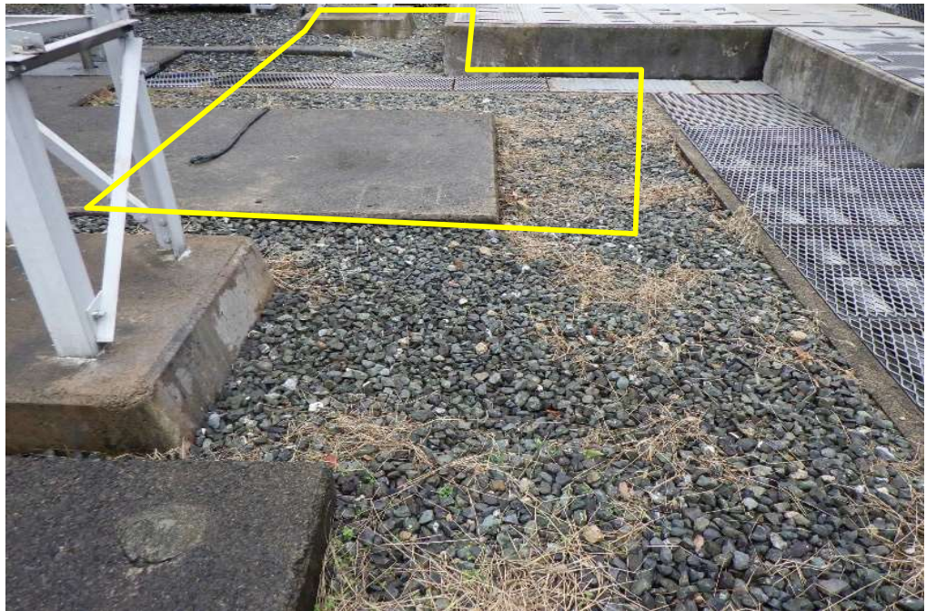
77kV作業用接地取付け箇所の足元の状況
