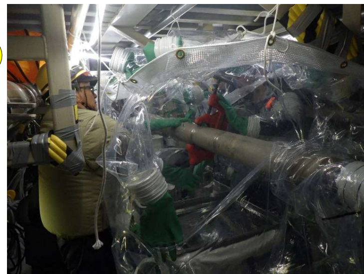
プラバッグを使用した作業イメージ (写真は配管切断の様子)
