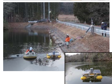
<福島県南相馬市(南迫溜池)での水中センサー設置作業>
